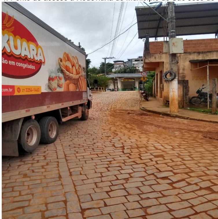
Figura 4. Ponte de acesso à Rodoviária do Município de São José do Calçado.
