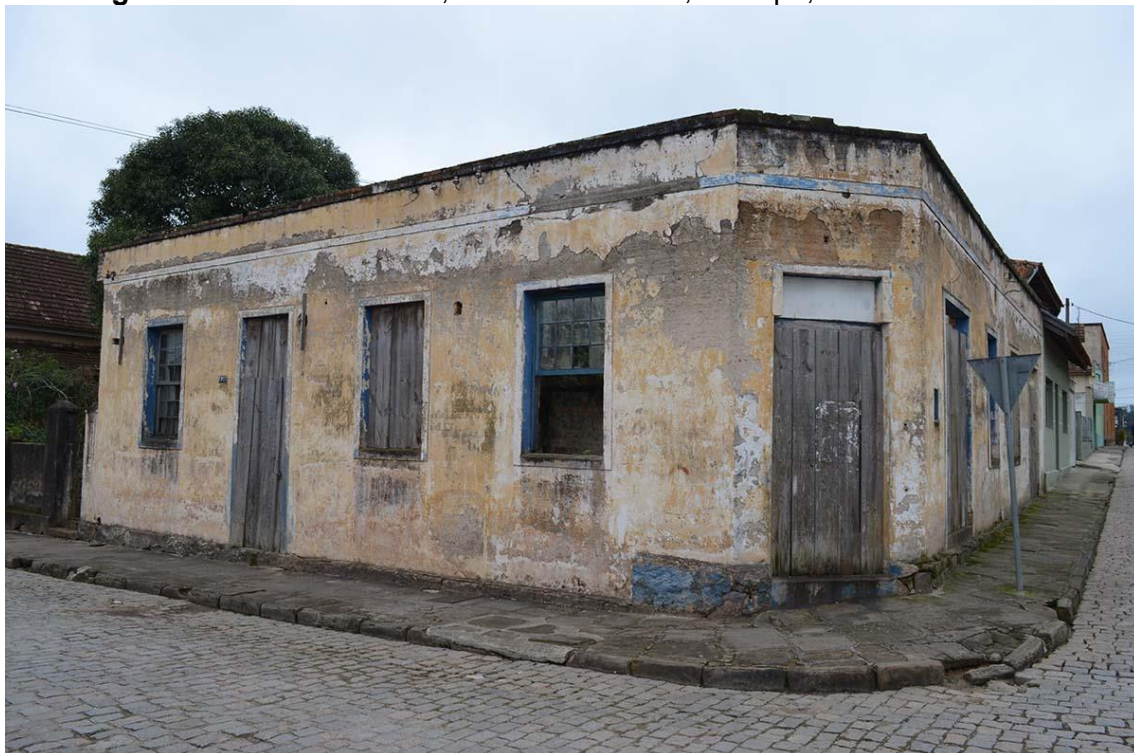
Figura 03. Imóvel tombado, mas abandonado, na Lapa, no Rio de Janeiro.
